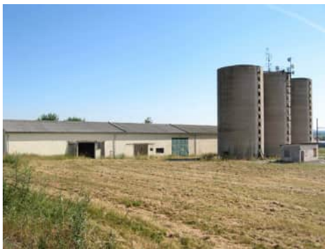
elektronické komunikační zařízení na zemědělských silech
