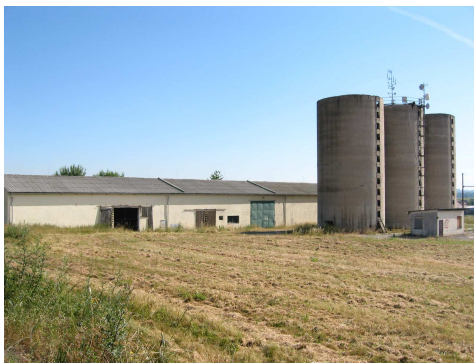
elektronické komunikační zařízení na zemědělských silech
